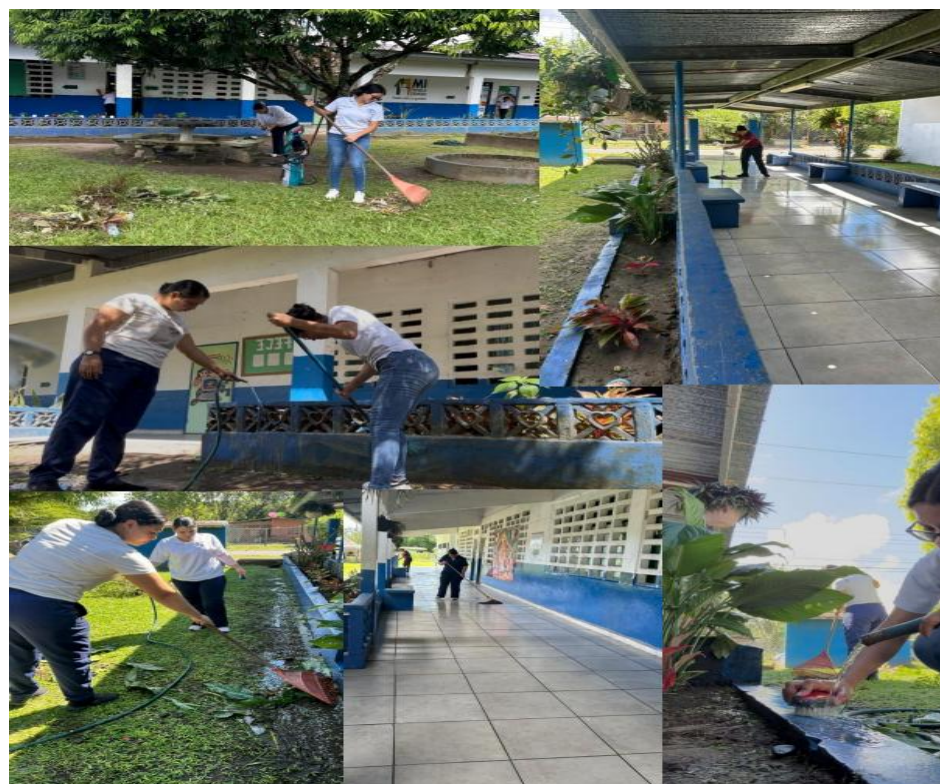
Jornada de Limpieza de las áreas verdes e infraestructuras del Centro educativo de Jacú
